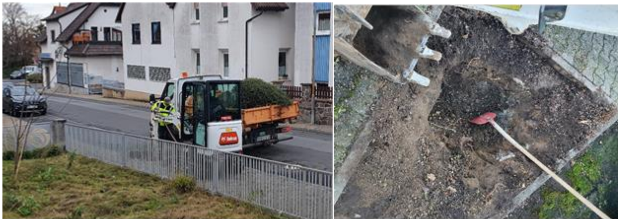
Abbildung 2 Beseitigung des Baumes vor Haus 3 samt Busch
